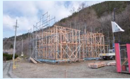
建設中の住宅の様子 (4月20日撮影)
