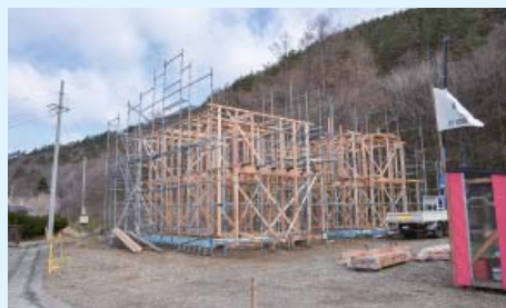
建設中の住宅の様子 (4月20日撮影)
