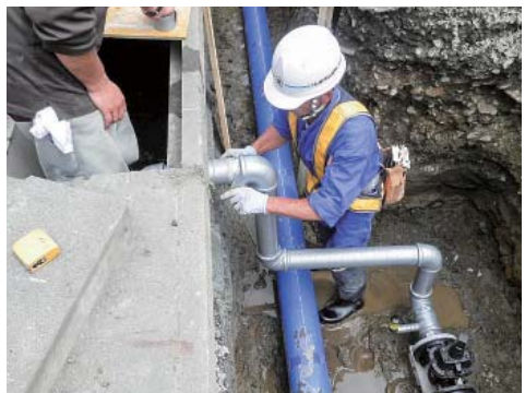
江刈地区水道整備工事は継続して進めます
