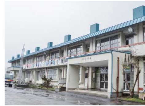
▲昭和47年に建設され、老朽化が著しい小屋瀬小学校の校舎。快適性の向上に向け、各教室の断熱工事などを実施します
