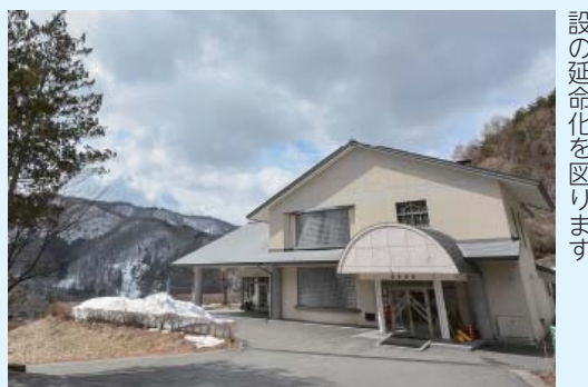
平成7年に建設された、くずまき斎苑(火葬場)。経年劣化している炉を中心に改修工事を行い、施設の延命化を図ります
