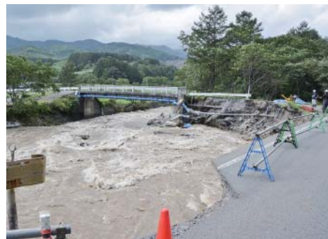
▲昨年8月の台風10号で被害を受けた道路や河川、橋、農業施設などの早期復旧に努めます（写真は町道本木遠矢場線の崩落現場）
