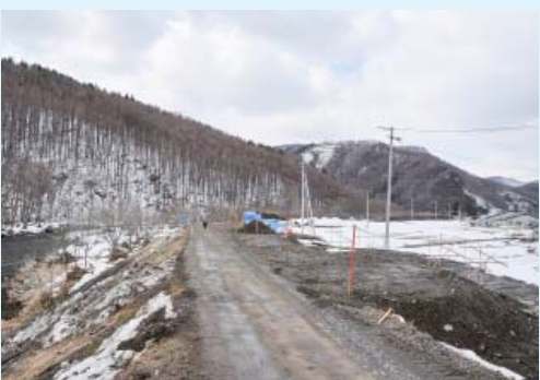
町中心部のバイパス道路機能を有する町道茶屋場田子線。早期完成を目指し、改良工事を進めます(写真は田の沢地区)
