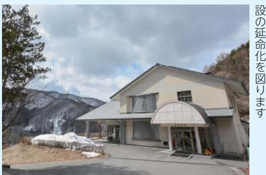
平成7年に建設された、くずまき斎苑(火葬場)。経年劣化している炉を中心に改修工事を行い、施設の延命化を図ります
