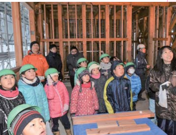
町産木材をふんだんに使用した建設中の校舎を見学する児童たち。目を輝かせながら町職員の説明に耳を傾けた
