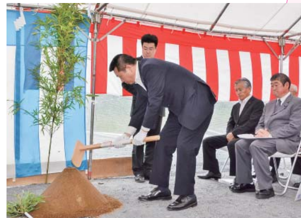
工事の安全を祈願し、神事で鍬入れを行う鈴木町長
