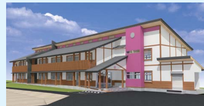
平成29年2月の完成を目指し、建築工事が進められている江刈小学校新校舎の完成イメージ
