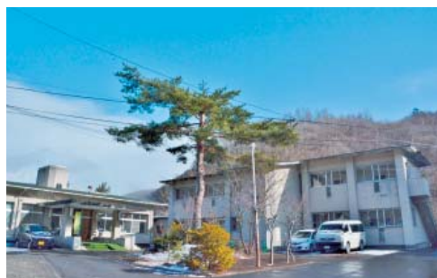
▲昭和48年に建設され、老朽化が著しい「養護老人ホーム葛葉荘」の改築工事を行います
