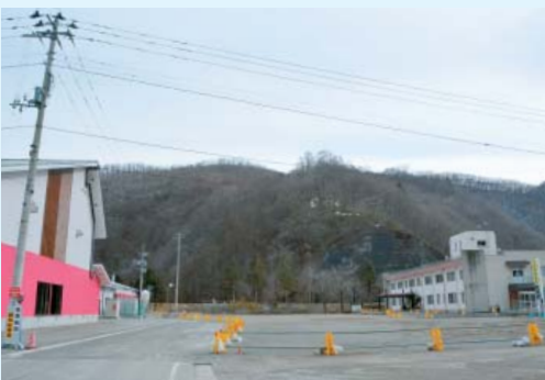
平成29年夏の開院を目指し、工事が進められている新葛巻病院の建設現場（写真右は現葛巻病院、左は葛巻小学校）
