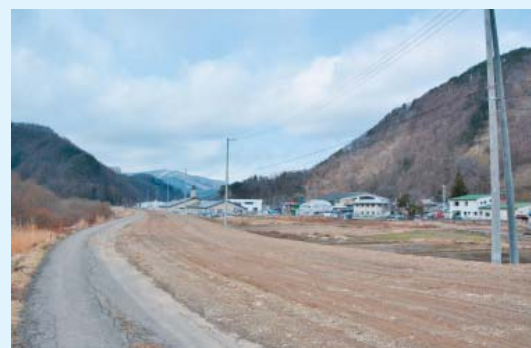
早期完成を目指し、改良工事が進められている町道茶屋場田子線（写真は田の沢地区）
