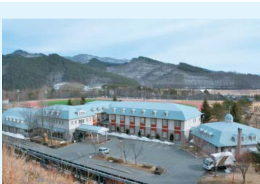
町の観光・交流拠点の充実のためのグリーンテージの改修工事を行います
