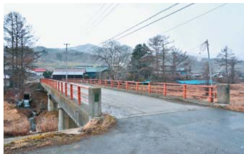
▲昭和44年に整備され、損傷が著しい「小苗代橋」の路面防水や防護柵塗装などの長寿命化修繕工事を行います
