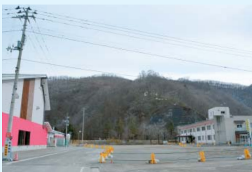
平成29年夏の開院を目指し、工事が進められている新葛巻病院の建設現場（写真右は現葛巻病院、左は葛巻小学校）
