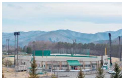
▲10月2日～4日、当町で行われる希望郷いわて国体の軟式野球競技。その会場となる総合運動公園野球場の改修工事を行います
