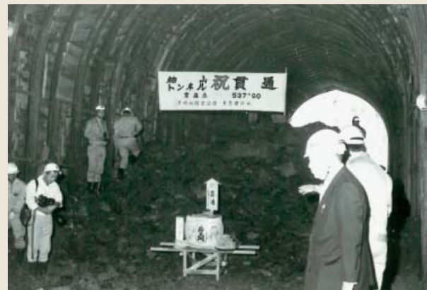
【昭和54年】北上山系開発事業で袖山トンネル完成
