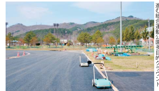
6月20日の完成に向けて順調に工事が進む総合運動公園多目的グラウンド
