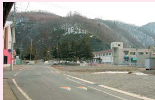
早期着工・完成に向け用地整備が進められている葛巻病院の建設予定地
