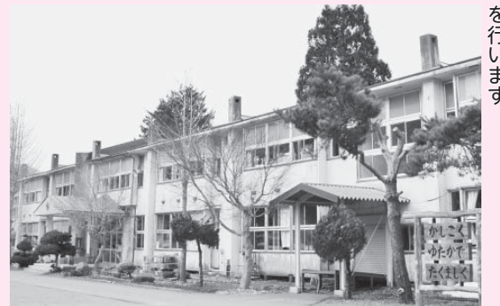
昭和38年度に建設され、老朽化が激しい江刈小学校校舎の改築工事を行います
