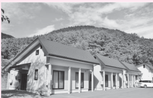
下町地区の定住促進住宅。移住・定住者が暮らしやすい環境をつくるため整備を進めます
