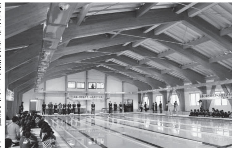
(資料写真) 昨年度完成した葛巻小屋内プール。構造材には町産カラマツ集成材を使用
