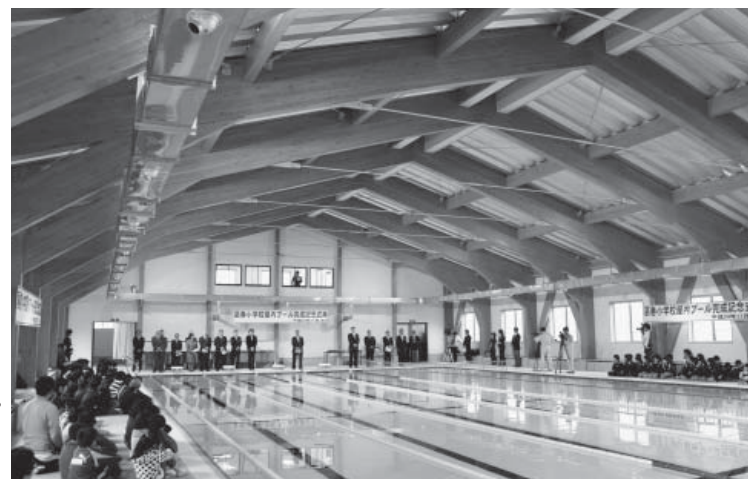
(資料写真) 昨年度完成した葛巻小屋内プール。構造材には町産カラマツ集成材を使用
