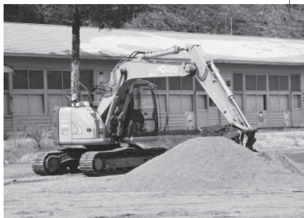
校庭を整地する重機
