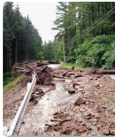
台風15号で川や沢が氾濫 豪雨で河川が氾濫し、道路や通信網、農作物に被害が出ました。(9/22 根地戸線)
