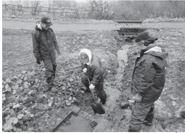
土砂などの除去作業をする会員ら
