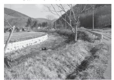
復旧工事を終えた同地区
