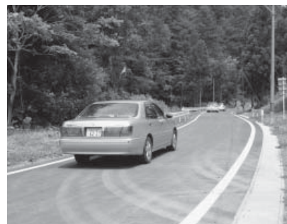
総延長5.15kmのうち2.39kmが道幅約5m、舗装されて立派に完成した町道根地戸線
