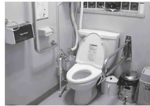
保健センター1階のオストメイト対応トイレ
