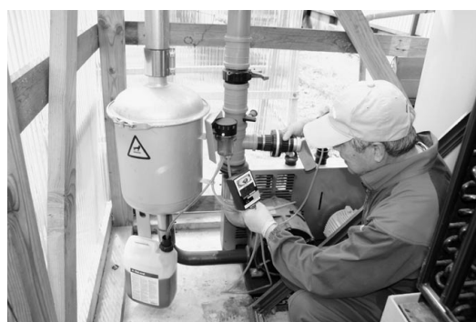
パイプラインのポンプ圧力を点検する専門員
