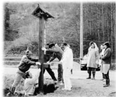
地区民が製作した「萩の里公園」の看板設置作業
