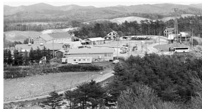
赤字縮小のため、町畜産開発公社に売り渡した葛巻財産区の土地（くずまき交流館プラトー周辺）
