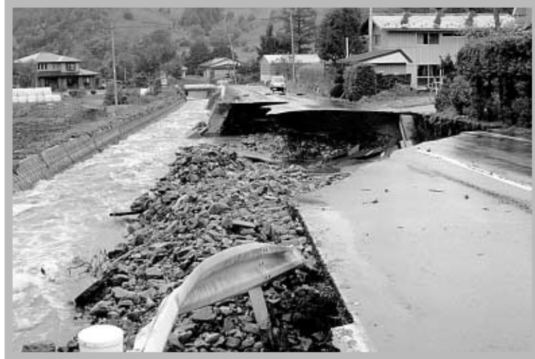
大量の沢水が流入し星野川が増水。道路の土がえぐられ、通行不能になった町道横打馬場線（8日午後2時＝横打）
