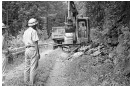
林道案内沢線の路肩に落ちた落石の撤去作業
