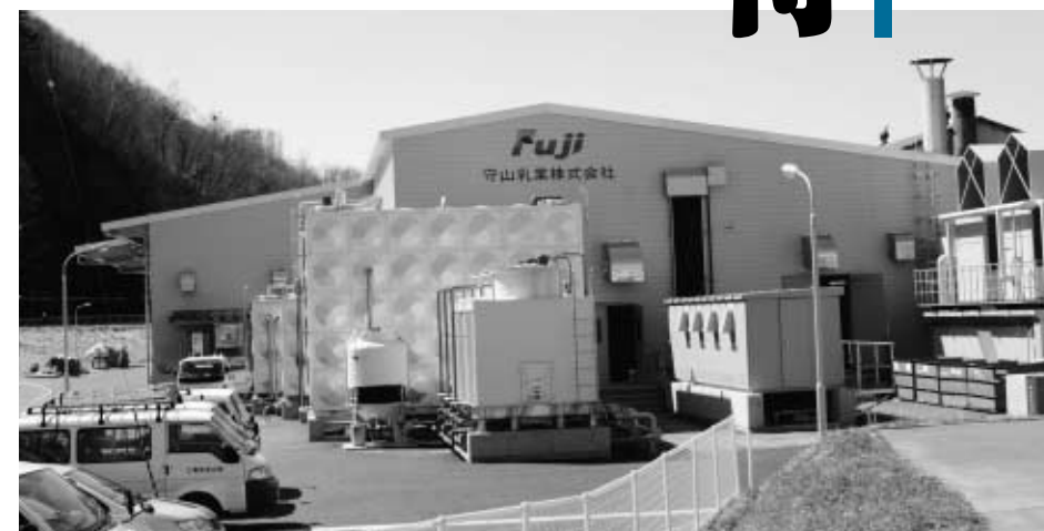
完成した新工場（モウモウ館側から撮影）
