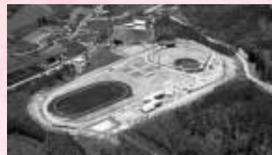
総合運動公園の全景 中央手前がグリーンテージ
