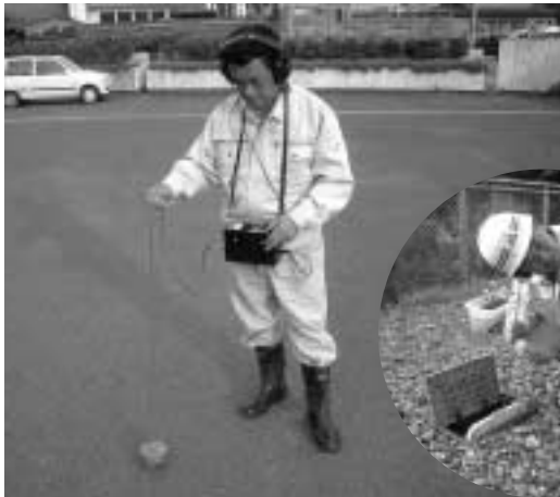
漏水が地表に出ない場合、漏水の音を感知することで故障箇所を探しています。(写真④給水管の漏水調査、⑤漏水探知機による調査)
