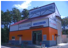
④木質バイオマスガス化発電 120kW H17 @くずまき高原牧場
