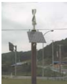
⑫風力&太陽光 ハイブリッド 街灯345W @道の駅
