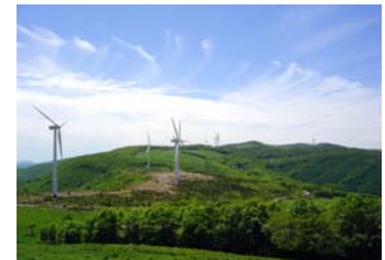
②グリーンパワーくずまき風力発電所 H15 21,000kW (1,750kW × 12基) @上外川高原
