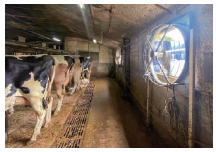
送風機を設置した牛舎
