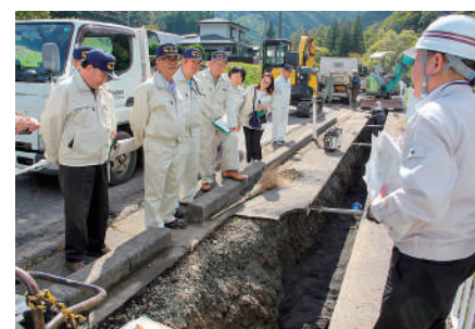
馬淵川地区水道管布設工事(岩瀬張地区)
