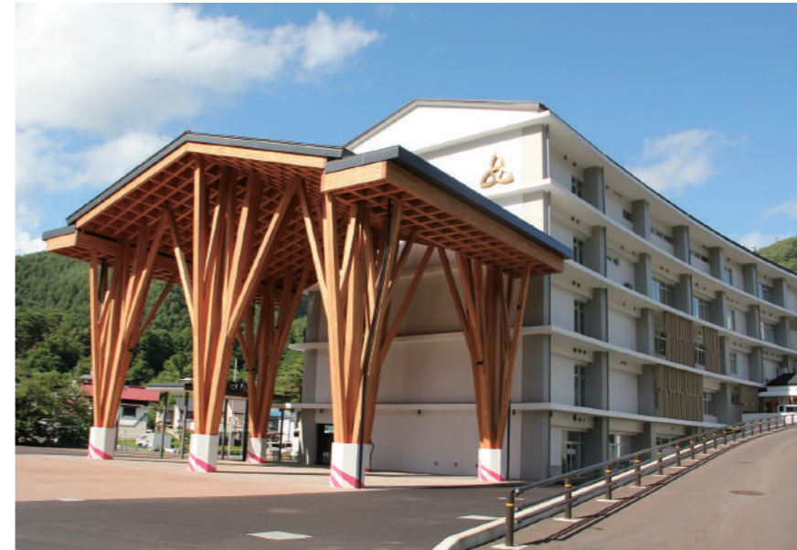
完成した大屋根広場「びっぐテラス」 (くずま〜の壁面には旧庁舎の町章が設置されています。)
