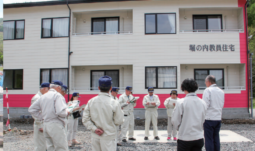
完成した堀の内教員住宅
