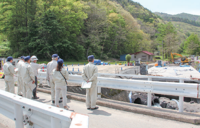
改良整備工事が進む町道葛巻浦子内線の状況を視察
