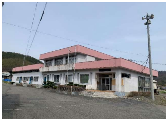
老朽化の進む茶屋場自治会館
