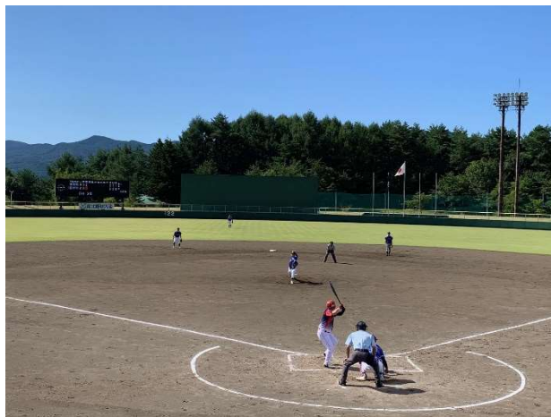
修繕予定の総合運動公園野球場
