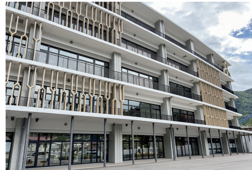
完成した役場庁舎
