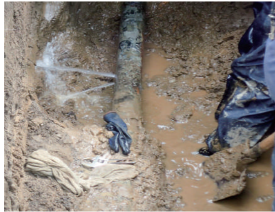
老朽化した水道管は漏水の恐れが高ま ります
