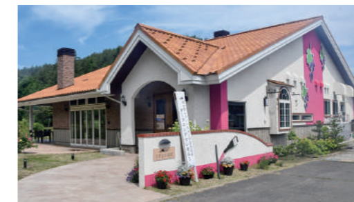
オープンした「道の駅レストハウスくずまき高原」
