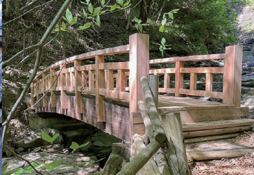
修繕が完了した七滝山村広場の木橋
