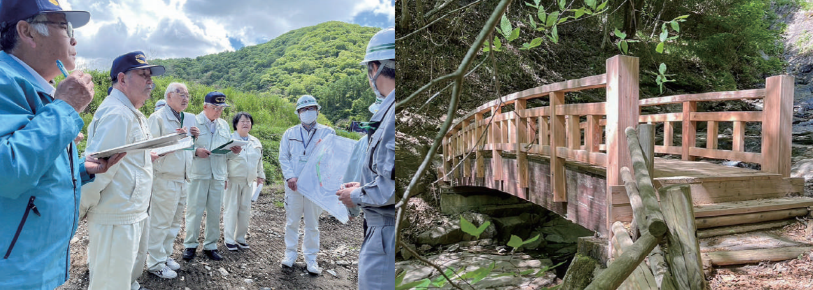
河川改良工事が進む馬淵川打田子地区
