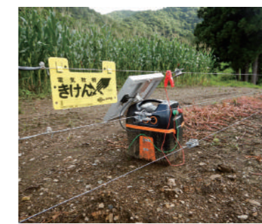
農地に設置された電気柵
