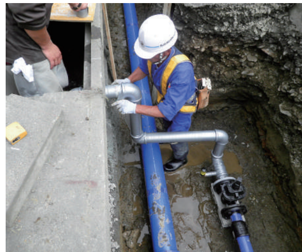
水道管修繕工事の様子（荒沢口地区）
