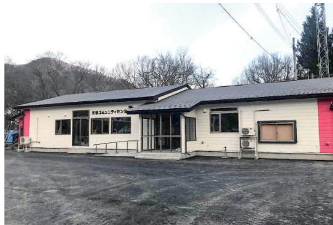
完成した冬部コミュニティセンター
