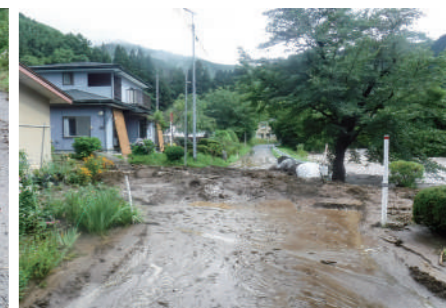
増水による路肩の崩落（上田野〜小田） 土砂で塞がれた町道（小田）
