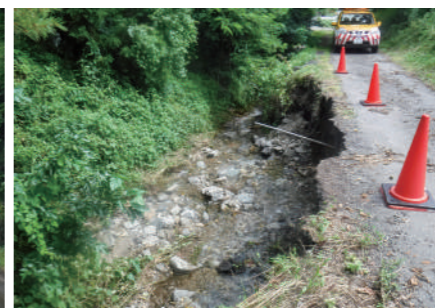
増水による路肩の崩落（上田野〜小田） 土砂で塞がれた町道（小田）
