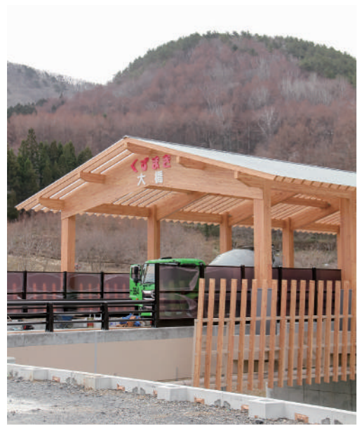
完成間近の大橋（4月6日）
