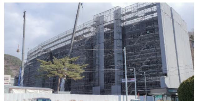
整備が進む役場新庁舎
