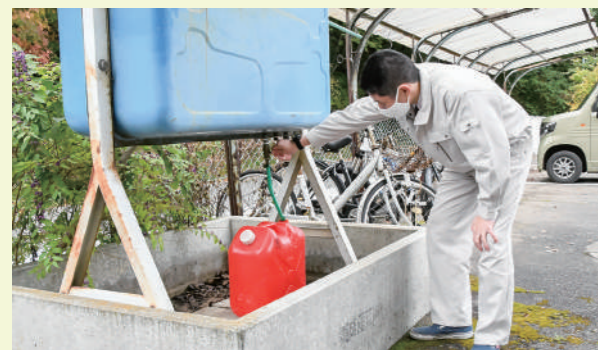
ホームタンクのバルブや配管を点検しましょう
