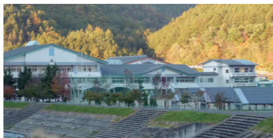
太陽光発電システムを備えた葛巻中学校新校舎が完成（平成12年）
