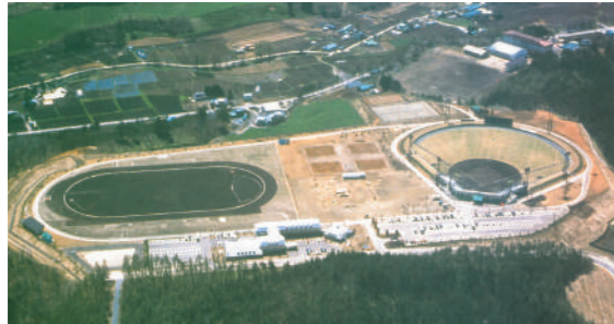
ふれあい交流施設（総合運動公園、ふれあい宿舎グリーンテージ）が完成（平成5年）
