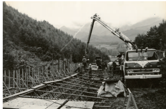
五日市から袖山へ続く道路の整備
