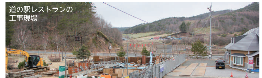
道の駅レストランの工事現場
